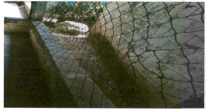
Reparación de muro perimetral de block, con tubo Hg y malta galvanizada, soleras intermedias y columnas.
