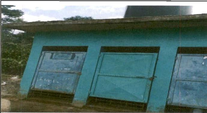
Mantenimiento a estructura (lijado, cambio de tubo, cepillado, sujeción, aplicación de pintura) a puertas servicio sanitario.
